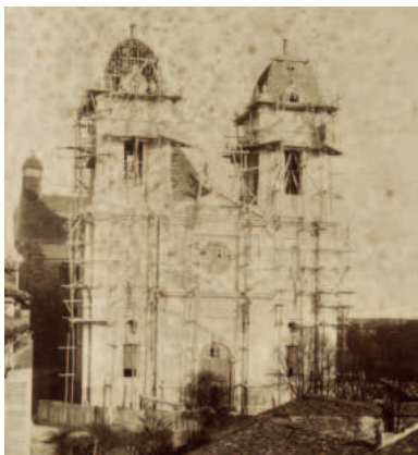
Façade occidentale en construction vers 1890
